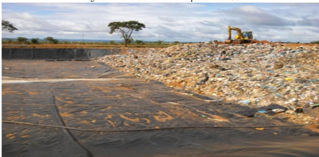
Figura 1: Aterro Sanitário Municipal de Jataí-GO
